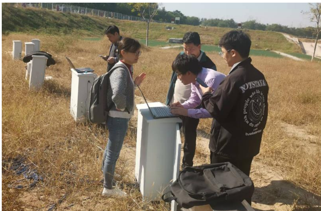
图 3 - 15 黄河防汛抢险基地堤防工程灾变过程智能监测平台搭建
